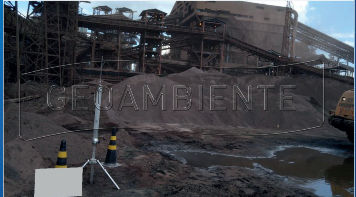
Pátios de estocagem de matéria-prima
